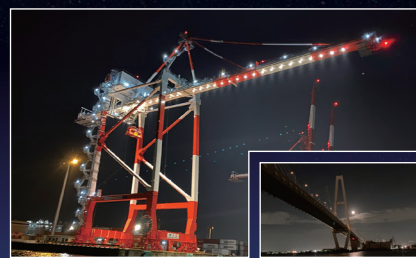
ガントリークレーン
